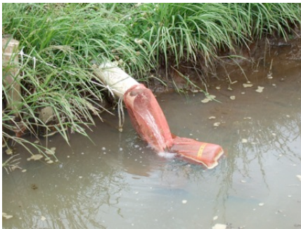
図-8. 水田の排水口に設置されたトラップ。
