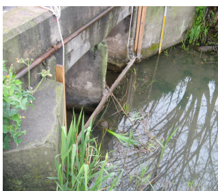
写真1. 本湖と内湖の接続水路に設置された水位調整用の堰板
